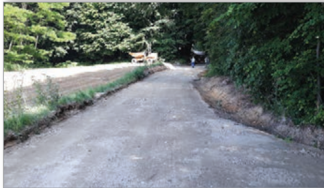
Odsek ceste v gradnji na Vanetini
